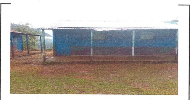
Foto 6: APLICACIÓN DE TORTA DE CONCRETO PARA COCINA MODULO 1
