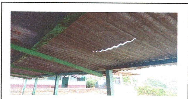
Foto 5: PANORAMA INTERIOR MODULO 1
